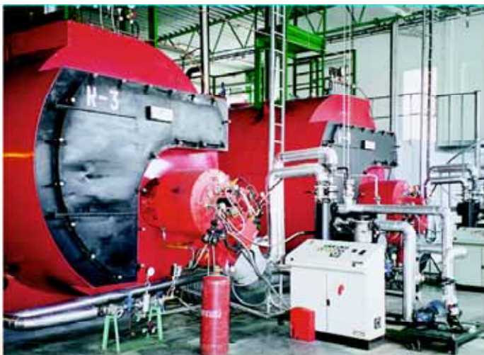
Горелки мод. PYR 6 GNR V (9.482 кВт) Работает поочередно на газе и мазуте. Установлена на котле с водяными трубами мощностью 2х10 т/час на нефтеперерабатывающем заводе Кеерли (Буркина-Фасо).
